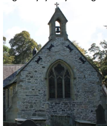
Mae'n bosibl bod y gwaith carreg gwahanol o dan y ffenestr orllewinol yn dangos bod drws wedi'i lenwi yno.
